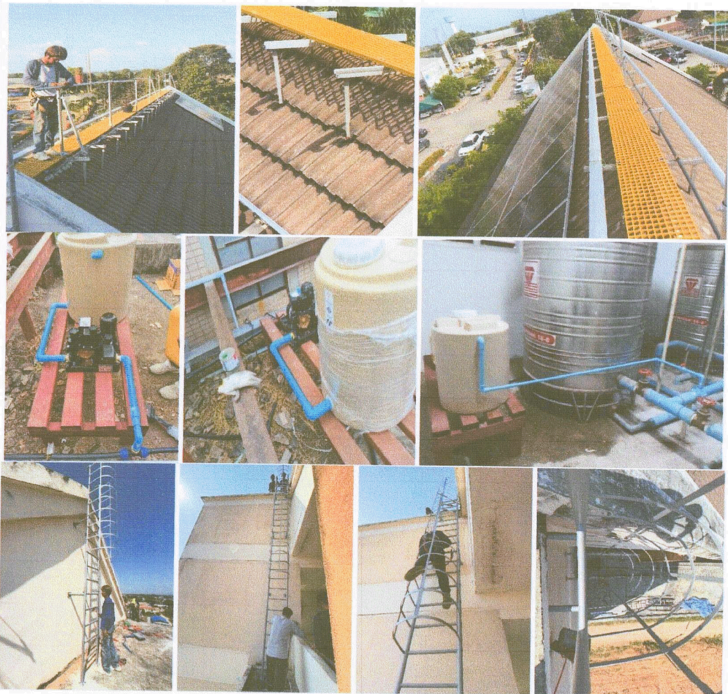
๙. รูปติดตั้งอุปกรณ์ความปลอดภัยและอุปกรณ์ทำความสะอาดแผง
