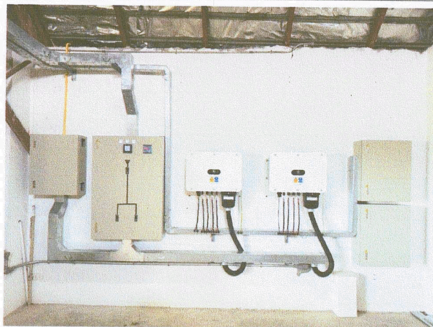
ภาพประกอบงานติดตั้ง อาคาร ๒
